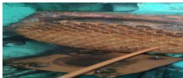
Gambar 3.3.2 Proses pembersihan LO Cooler (Sumber SPB LAIS)
