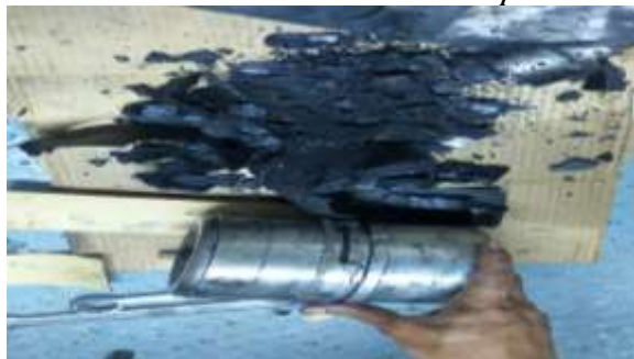
Gambar 3.2.1 Perawatan LO Separator
