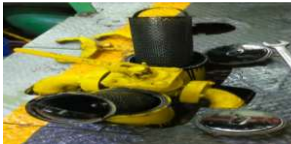
Gambar 3.1 Perawatan LO Strainer
