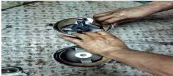
Gambar 3.2.2 LO Separator setelah dibersihkan
