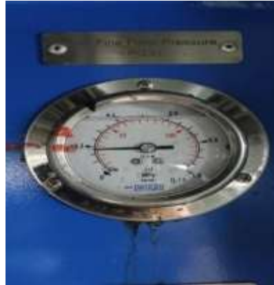
Gambar Tekanan Fine Filter 10 \mu\text{m} dan 3 \mu\text{m} yang tinggi pada saat alarm high pressure dan high PPM
