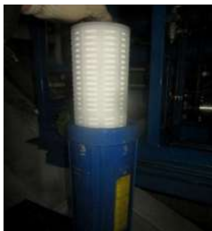
Gambar Penggantian Fine Filter 10 \mu\text{m} dan 3 \mu\text{m} pada reverse osmosis plant
