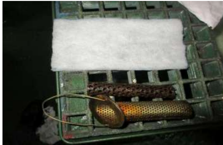
Gambar Basket strainer yang sudah dibersihkan
